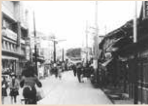
昭和37年東町本通り
